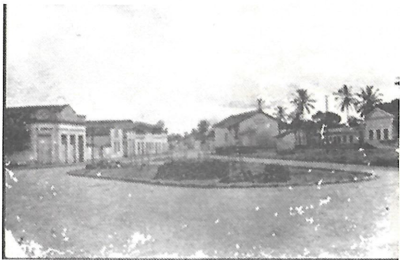
A estação de Sapé, foto sem data. Cessão Jônatas Rodrigues
